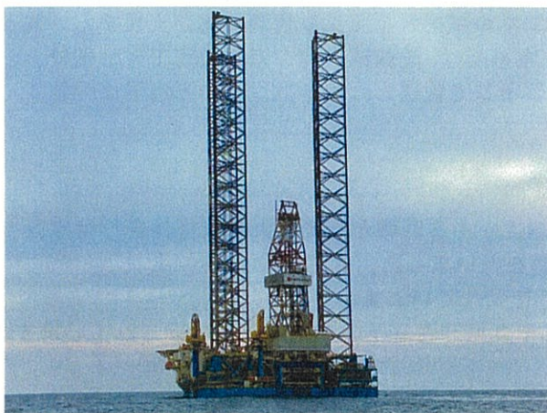
掘削装置(近くから見た様子)
