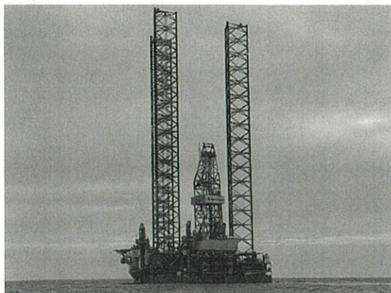
掘削装置(近くから見た様子)
