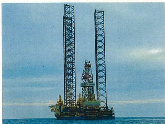
掘削装置(近くから見た様子)
