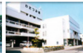
豊浜町老人介護保健施設 豊浜町老人介護支援センター
